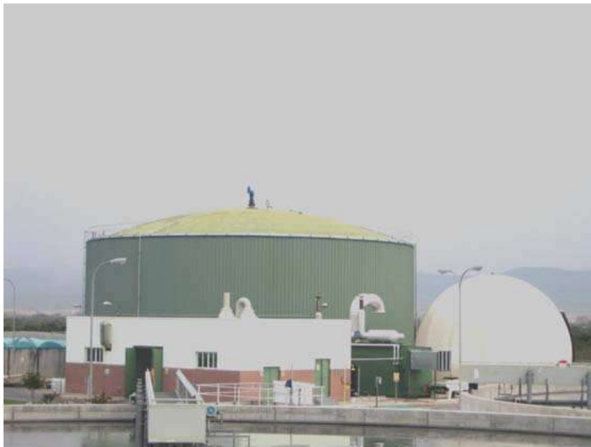
Figura 3. Reactor anaerobio de digestión de lodos de EDAR.
